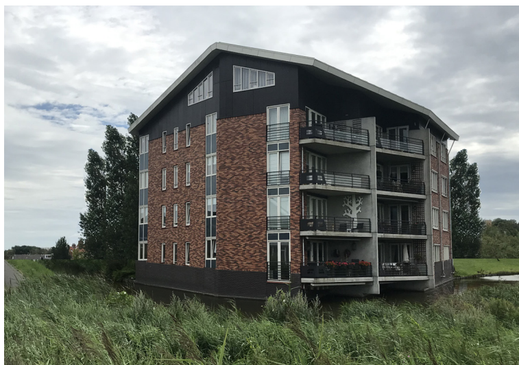
Voorbeeld van buitenruimten die geen afbreuk doen aan het hoofdvolume van het gebouw. Gebouwen in relatie tot de natuur.
