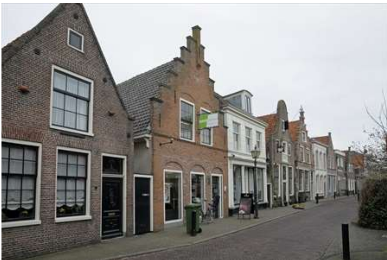
Situering van het object in de westelijke gevelwand van de Spuistraat.
