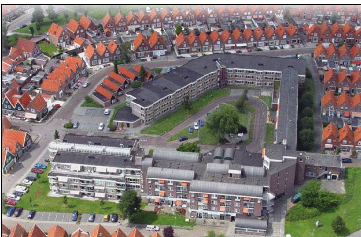
Afbeelding: huidige situatie St. Nicolaashof gezien vanaf het oosten
