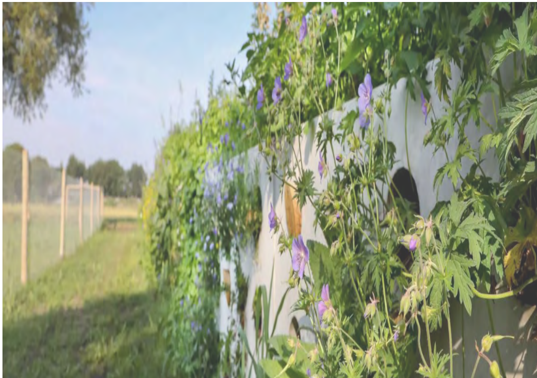
Betonnen keerwand met begroeiing
