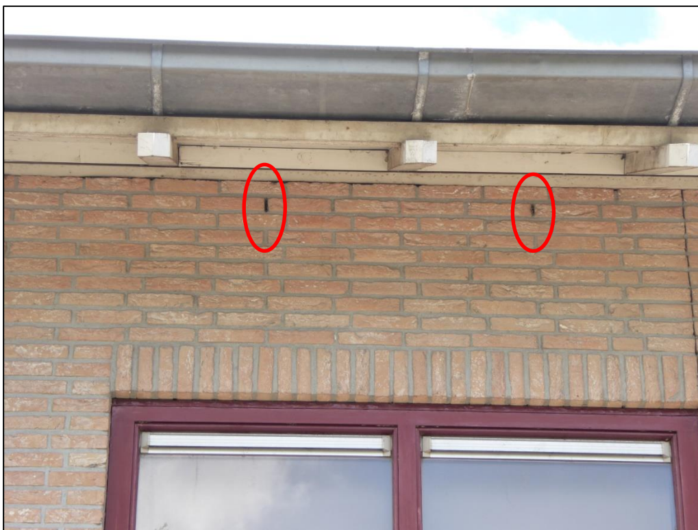
Open stootvoegen in bebouwing in plangebied.
