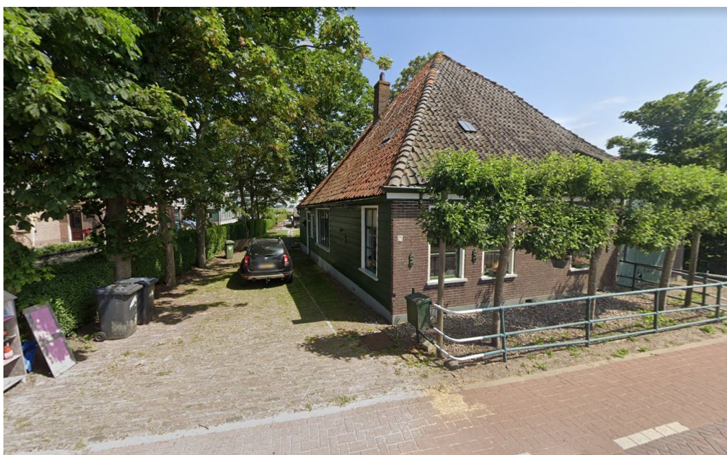
Figuur 8: Overzicht van het plangebied gezien vanaf de Kwadijk (Google Street View, juni 2022).
