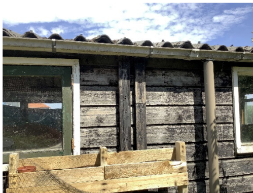
Foto 6 Afwatering asbestdak
