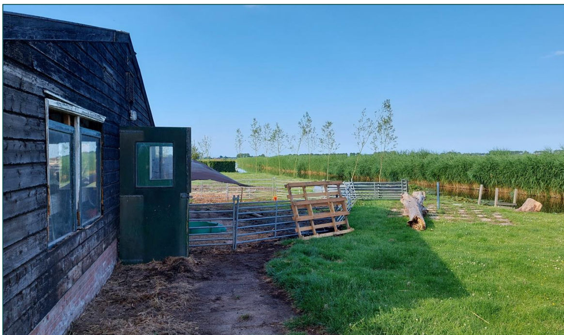
Figuur 2 De te slopen stal op de planlocatie.
