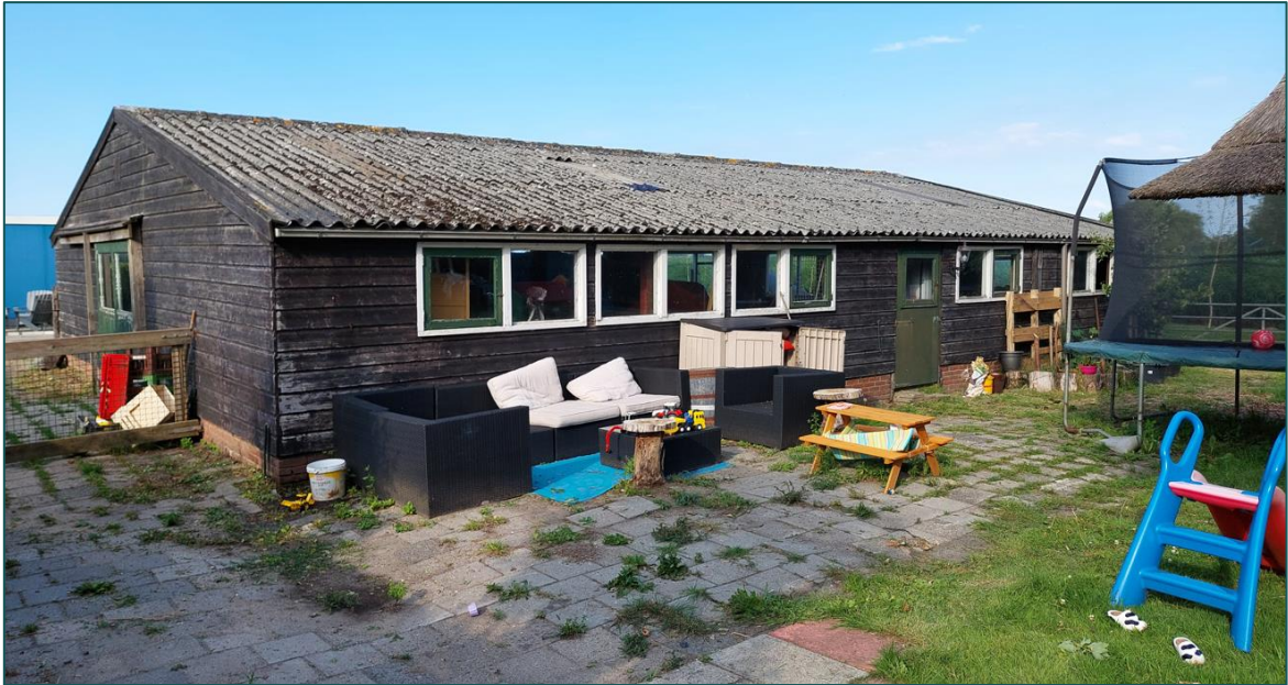
Figuur 1.3 De te slopen stal op de planlocatie.
