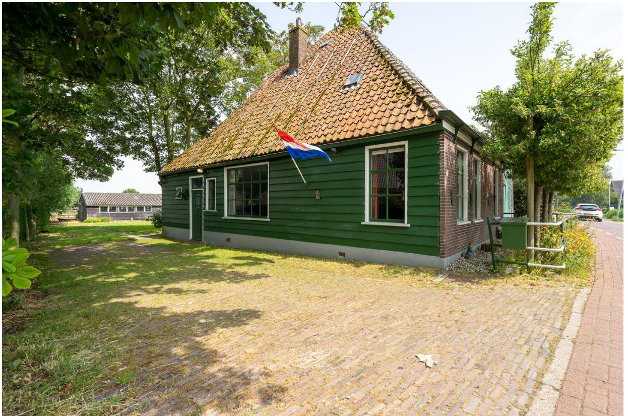
Figuur 2: foto van de bestaande boerderij.
