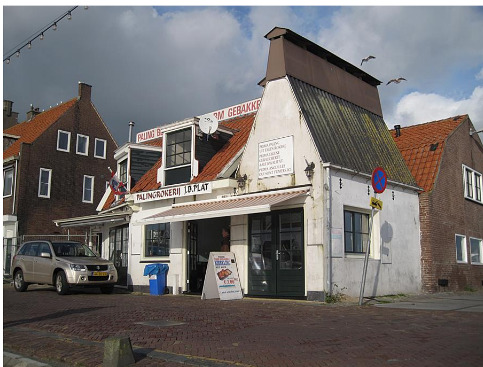
Foto van het pand aan de Haven
