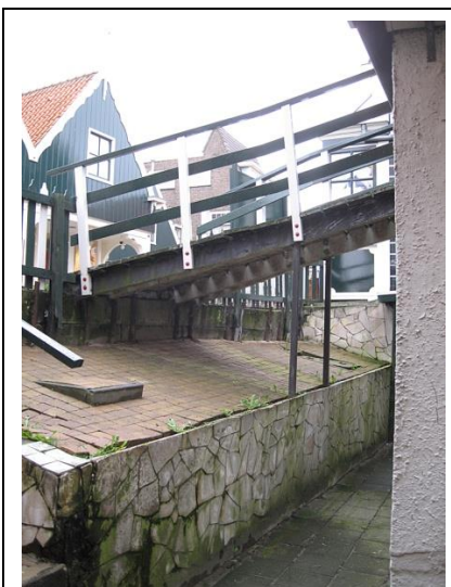
Haven 2 brug looppad
