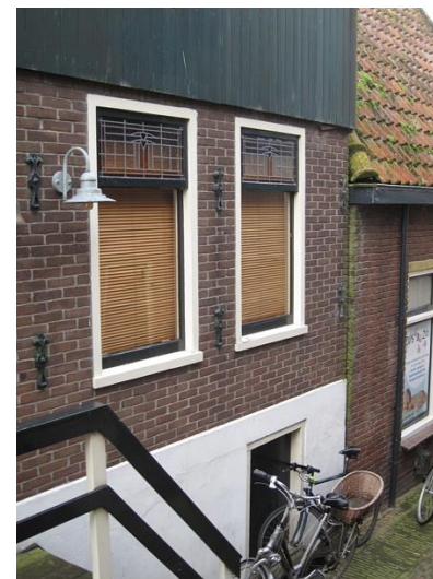
Oude Draaipad 3 kelderraam
