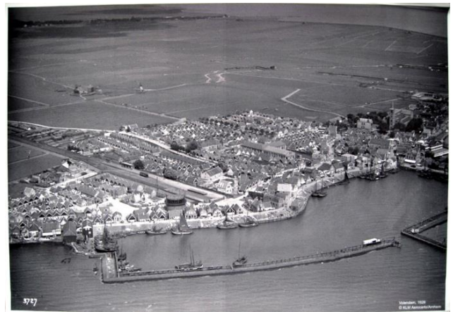
Situatie haven en achterliggend gebied 1928
