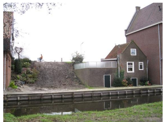
Gat gevelwand bij Noordeinde 65
