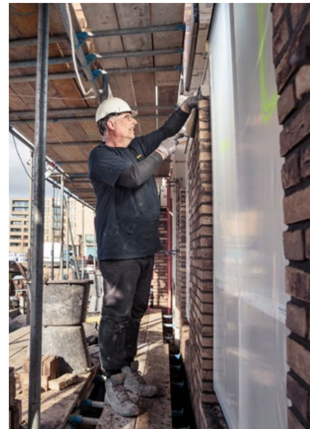
Een bezoek of rondleiding aan de bouwplaats is altijd mogelijk
