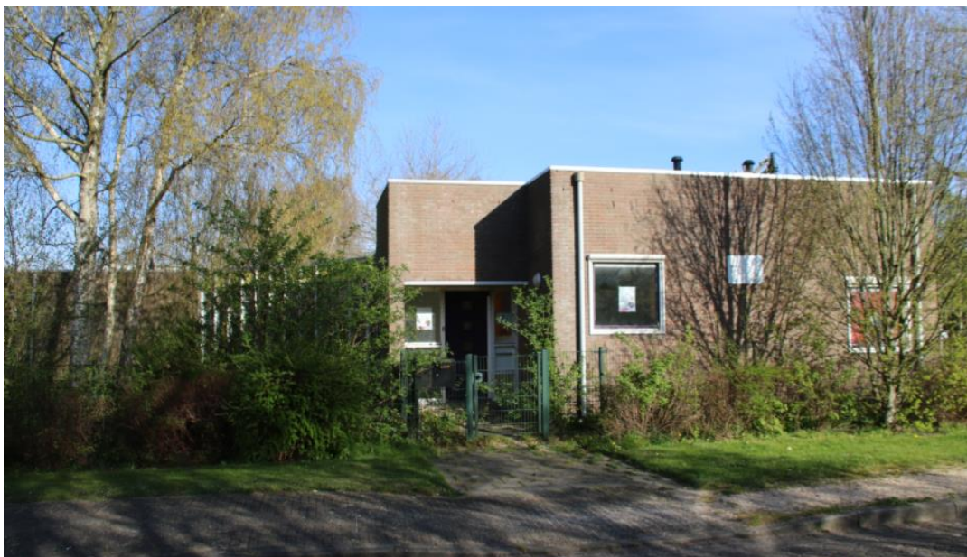
Foto bestaande bebouwing met ongeschikte delen voor vleermuizen
