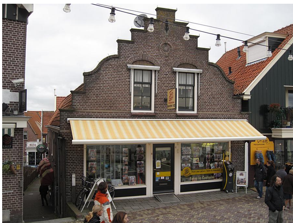
Foto van het pand aan de Haven
