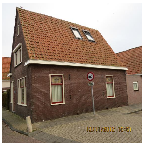
Voorgevel en rechter zijgevel
