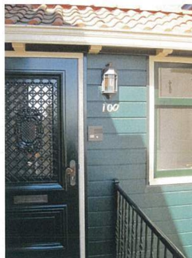
Haven 100 terugliggende ingang
