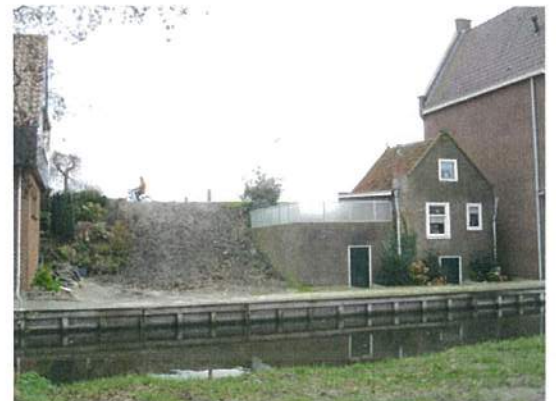
Gat gevelwand bij Noordeinde 65
