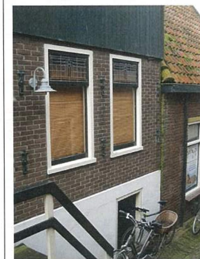
Oude Draaipad 3 kelderraam
