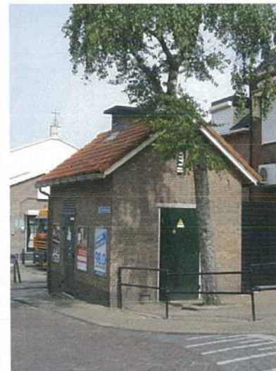
Meerzijde 26 (trafo) Volendam
