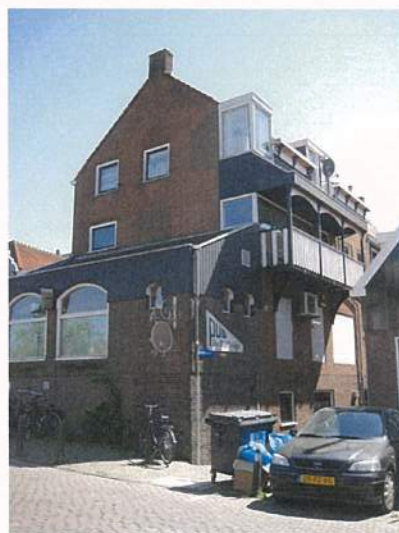
Brugstraat 3-3a achterkant
