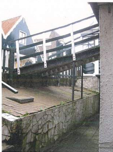
Haven 2 brug looppad
