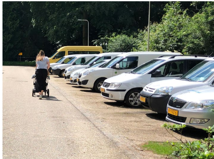
Halfverharding voor parkeerplaatsen, rijbaan in asfalt met strooilaag
