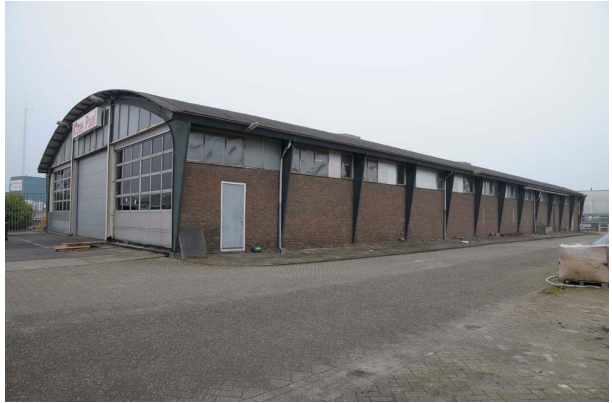
Overzicht van de rechter zijgevel van de voormalige autobusremise, waarop de constructie in de vorm van zware stalen boogspanten te zien is.
