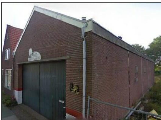
Afbeeldingen: de foto's tonen dat de dichte enkelsteens muren van 't Marken 9a. De boeidelen sluiten voorts strak aan. Op de foto rechts is zichtbaar dat het dak gesloten is en geen schuil/toegangsmogelijkheden biedt.
