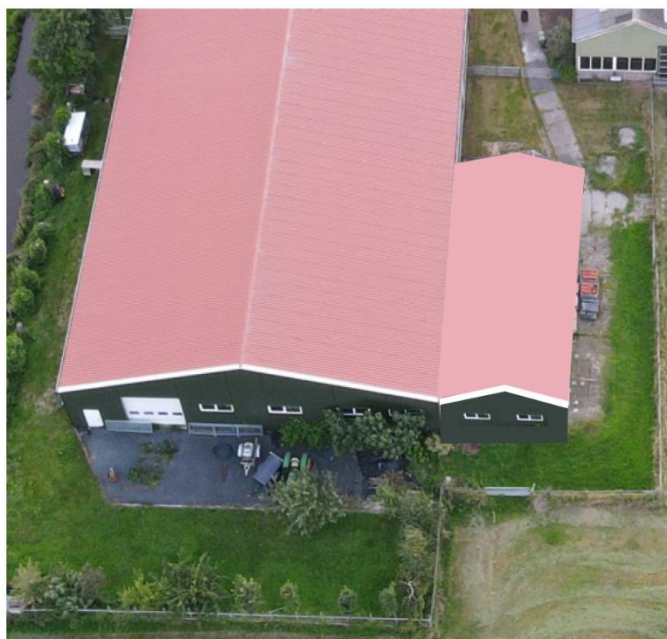
Impressie van de loods, het rechter bouwdeel
