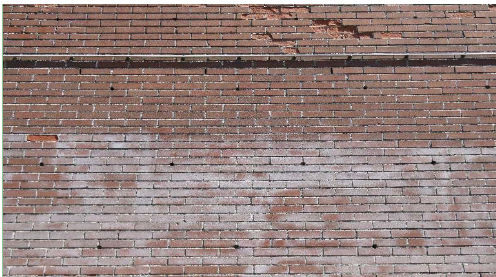
Muur van de Seinpaal met spouwgaten en geboorde gaten.
