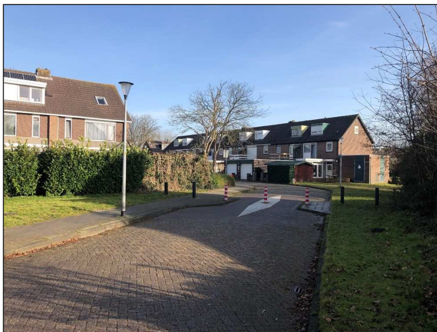
Figuur 1.3: De Pieter Claesstraat blijft afgesloten voor gemotoriseerd verkeer
