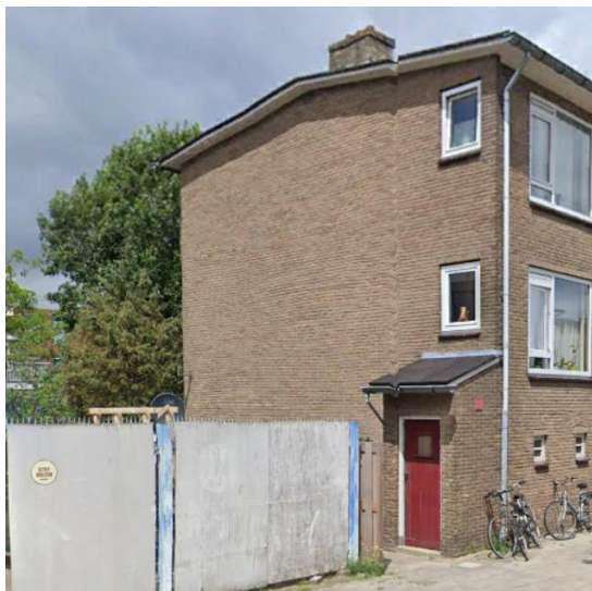
Afbeelding: gevel Pr. Irenestraat 5
