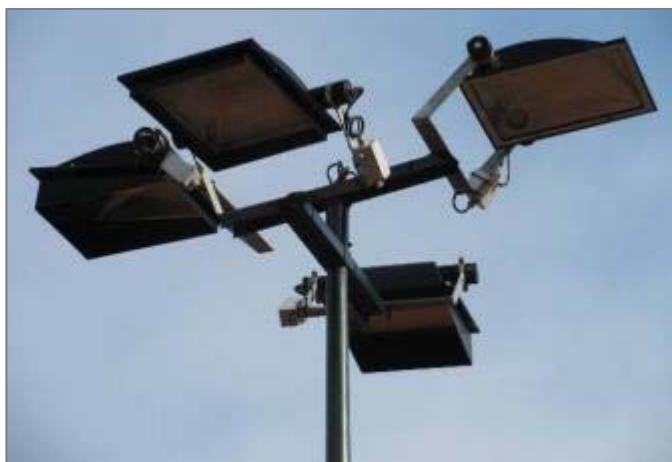
Figuur 10. Vleermuisvriendelijke verlichting, gedempt oranje licht, aangepaste armaturen zonder lichtverstrooiing en toepassen op korte palen.
