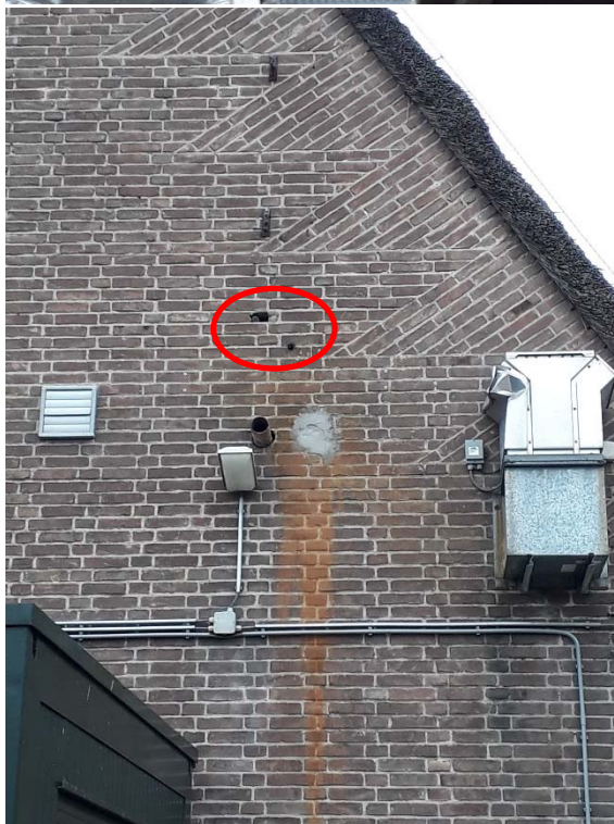
Figuur 6. Potentiële invliegopeningen voor vleermuizen: open delen in het dak (links- en rechtsboven), losgekomen voegsel en stenen in muur (links- en rechtsonder). Foto's: Royal HaskoningDHV, 2019.
