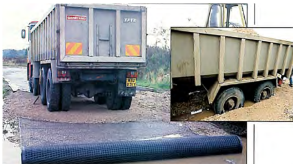
Figuur 4.17 Voorbeeld van wapening wegconstructie
