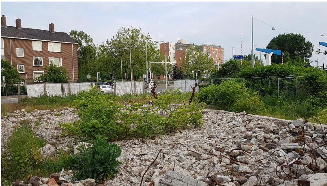
Figuur 3.2. Puin van het gesloopte gebouw, onkruid en rommelhoekjes.
