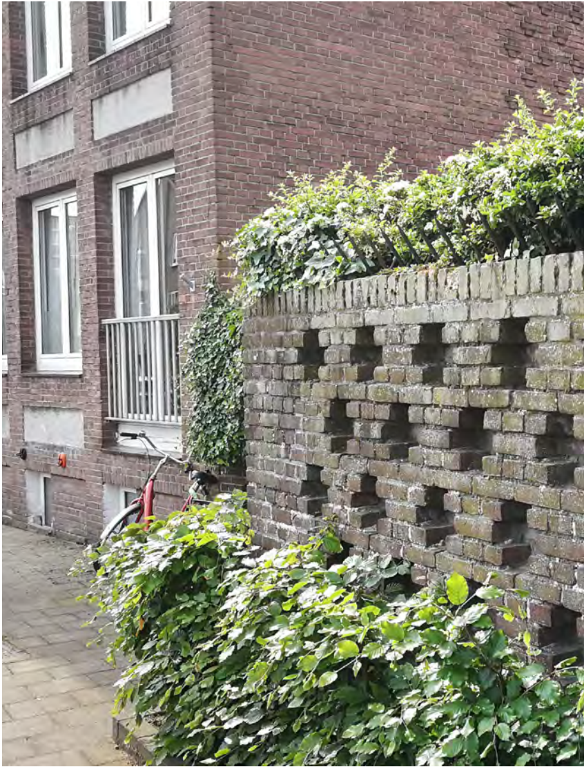
bijzonder metsewerk doorgezet in tuinmuur
