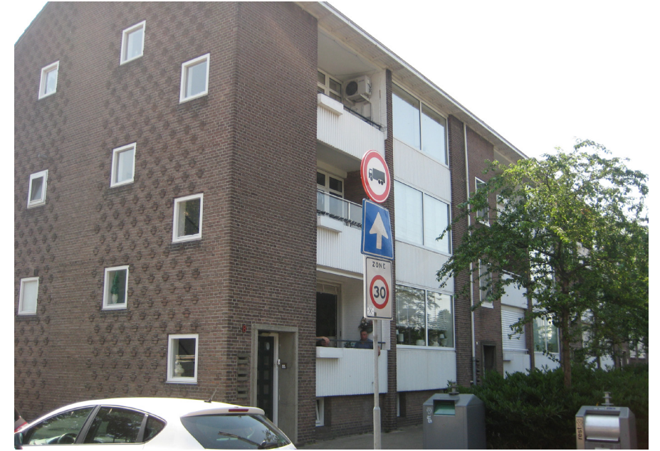
Architectuur met baksteen, details zijgevel, open verticale raampartijen
