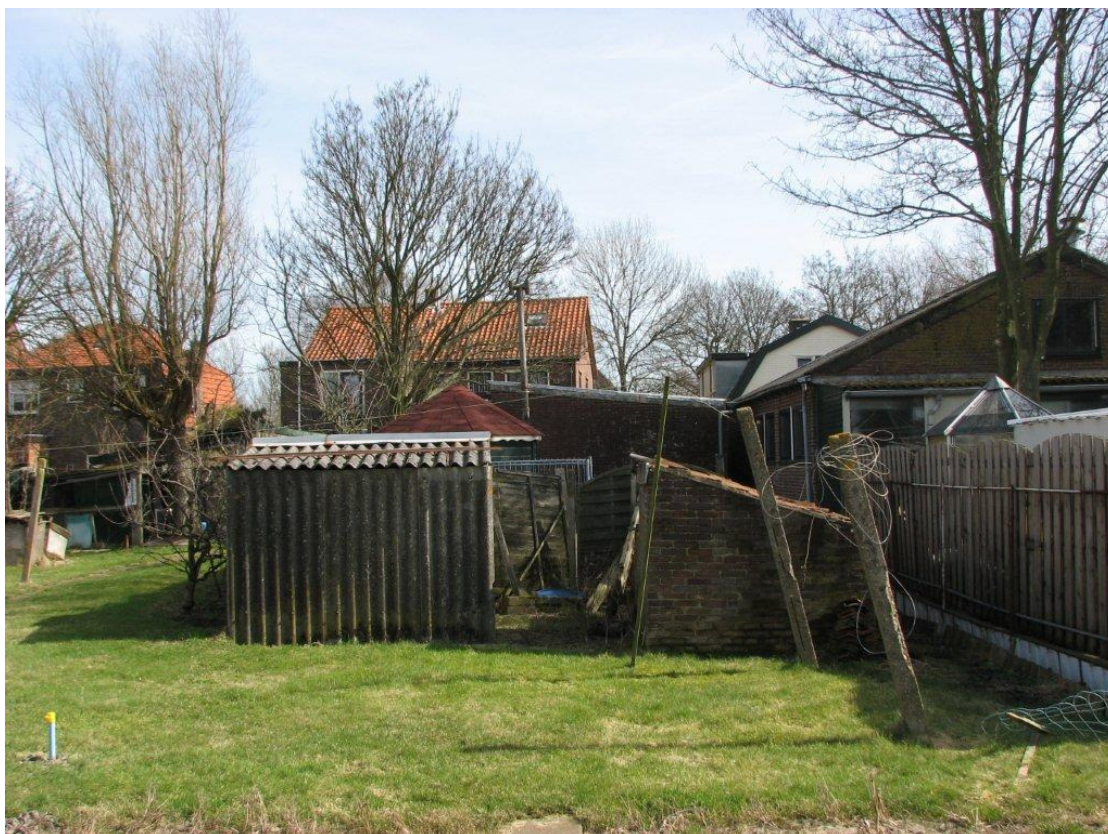
Foto 3 Zicht op het zuidoostelijke deel van de planlocatie: te slopen schuurtjes.
