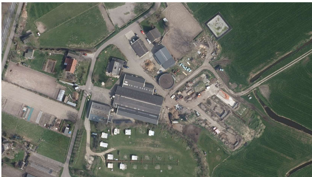
• Figuur 2: Luchtfoto locatie Hollaan 2 (bron foto: Street Smart bij Cyclomedia)
