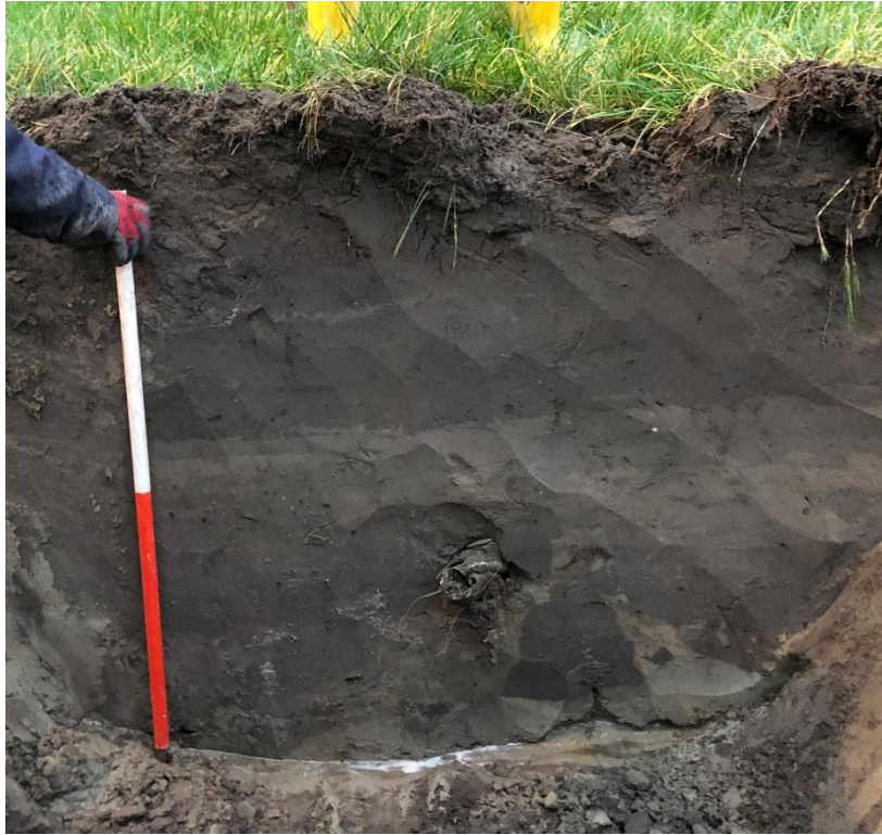
Foto van Kijkgat KI (met drainage pijp)
