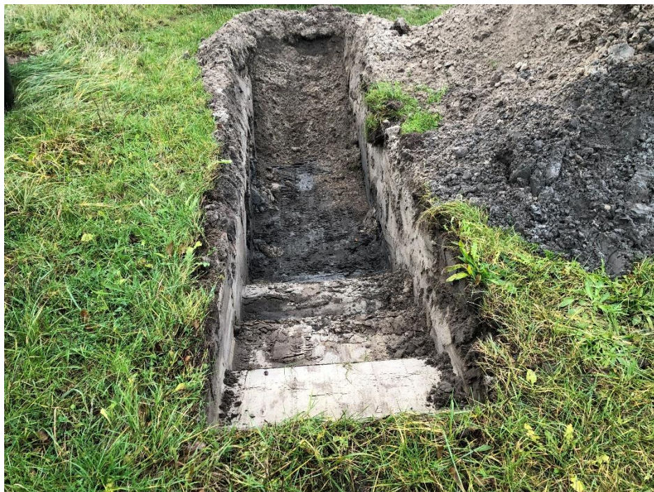
Foto van Kijkgat BZ8. Kijkgat eindigt in puinstort met grondwater.
