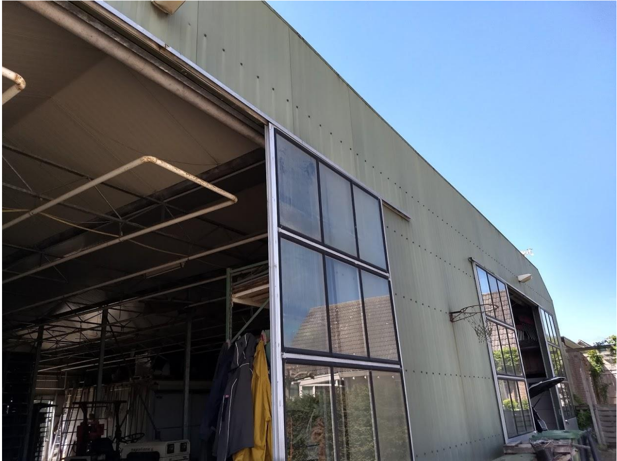
figuur 8: loods op locatie, geen openingen of kieren ie geschikt zijn voor vleermuizen
