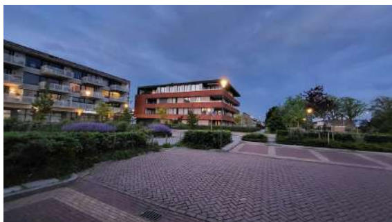
Foto 3: appartementencomplexen zuidelijk van het winkelcentrum
