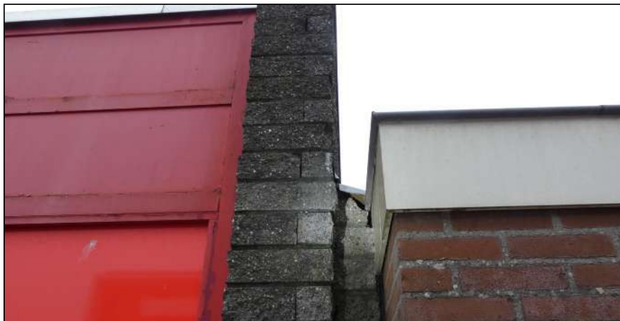
Figuur: Ruimte onder een loodflap dat geschikt is als invliegopening voor vleermuizen.
