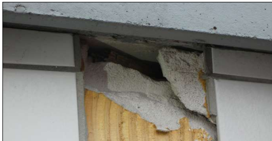
Figuur: Kapotte tegel in een muur waar vleermuizen gebruik van kunnen maken.
