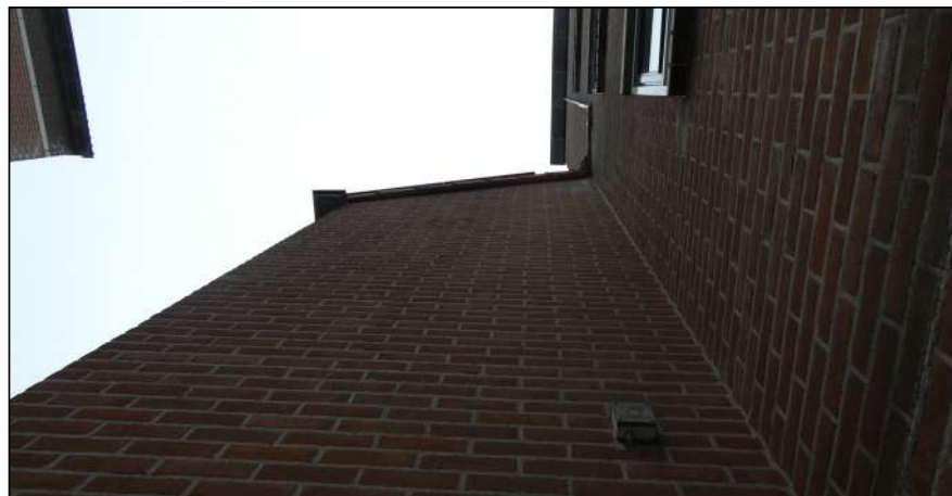
Figuur: Onderaanzicht van het dak buiten het plangebied met ruimte tussen de dakpannen.
