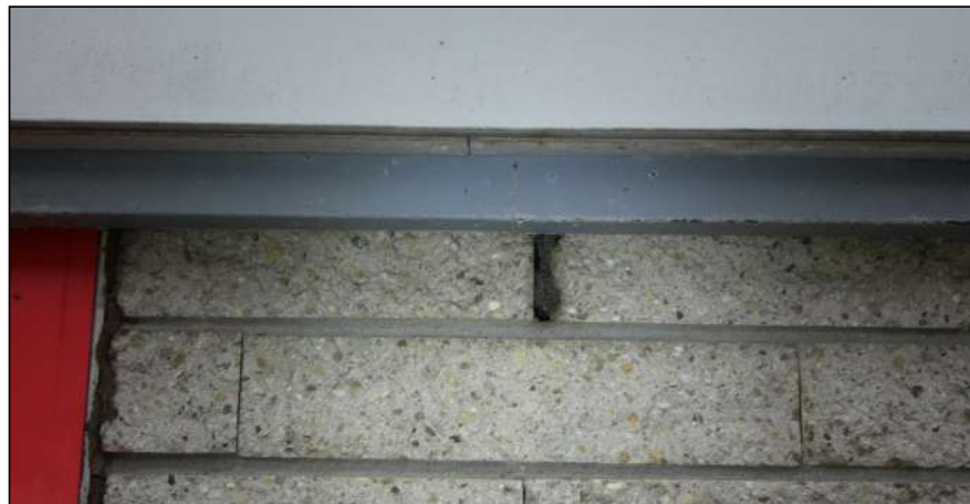
Figuur: Met staalwol dichtgezette stootvoeg.
