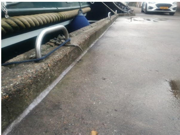
Fotonummer: 3 Omschrijving: Aansluiting op randbalk aan waterzijde.
