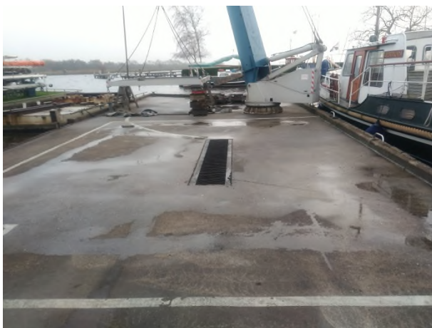
Fotonummer: 1 Omschrijving: Aanzicht afspuitplaats.
