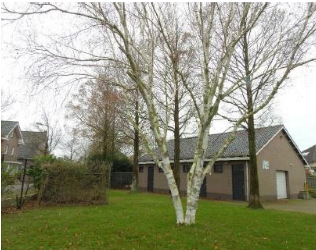
Foto's bestaande situatie
