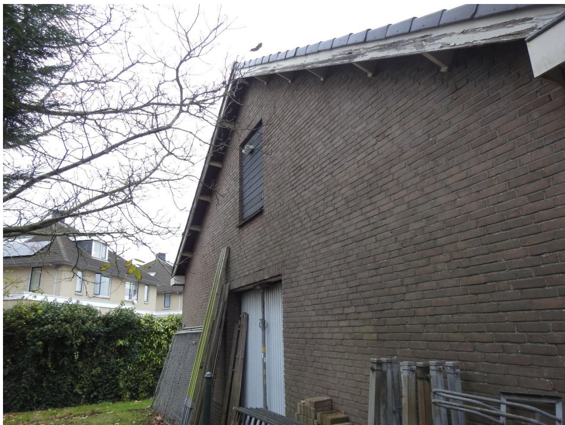
Figuur 2.4 Zuidzijde van de te slopen schuur.
