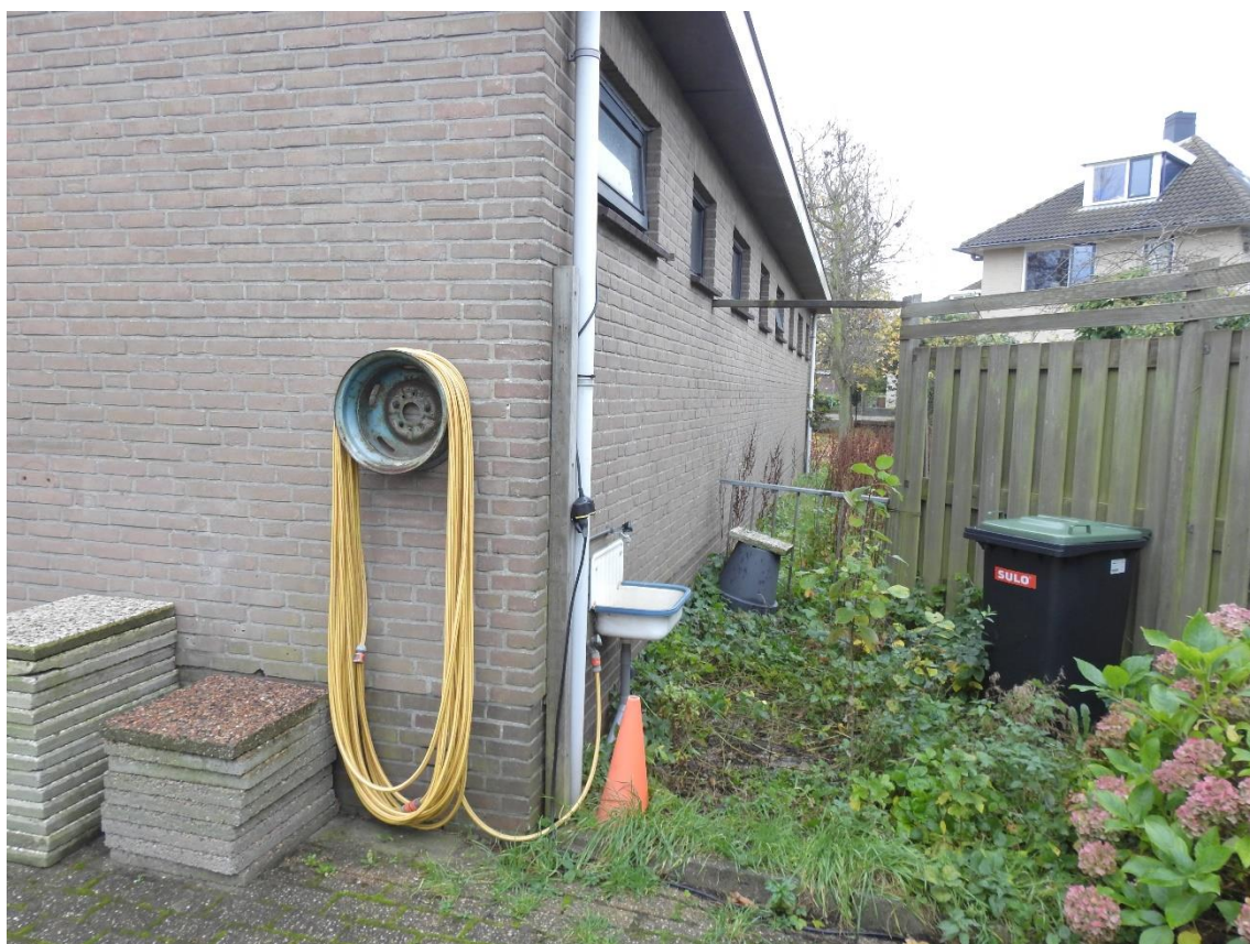
Figuur 2.5 Westzijde van de te slopen schuur.
