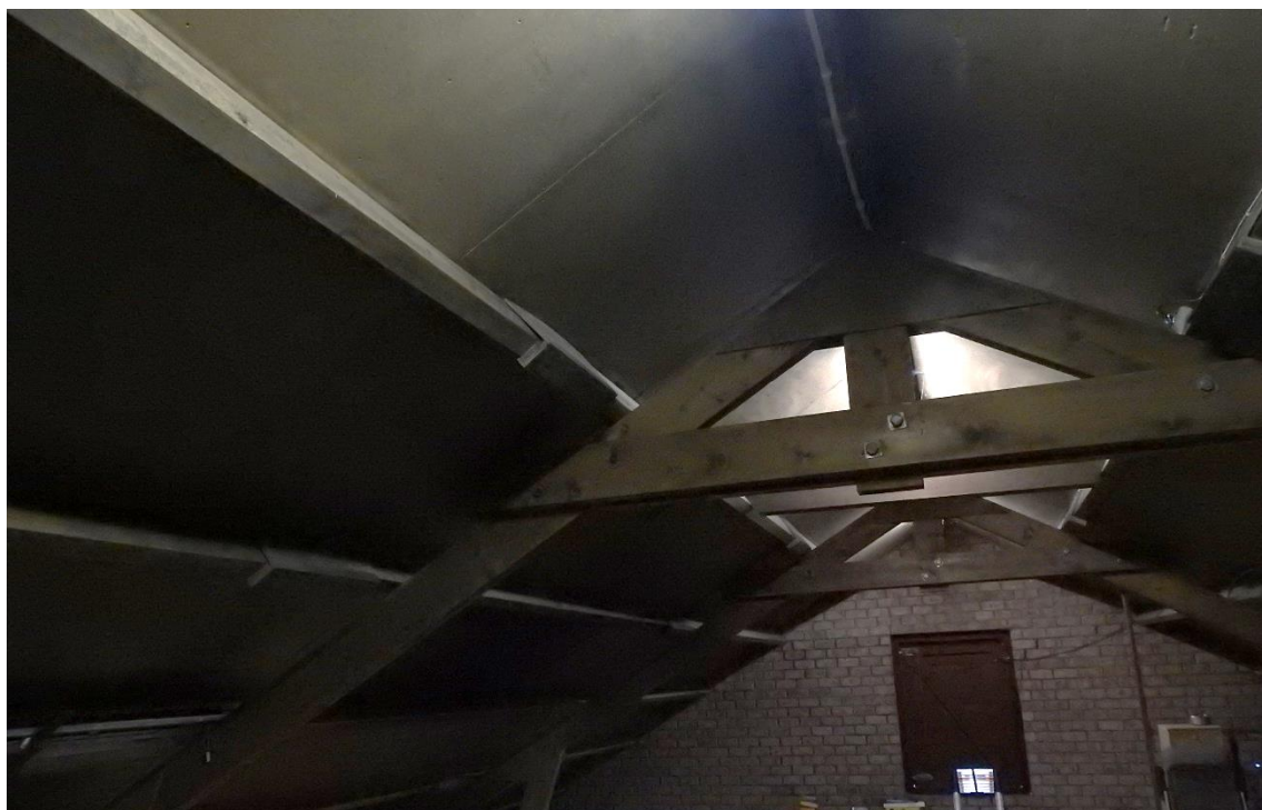
Figuur 2.6 Binnenzijde plafond van schuur
