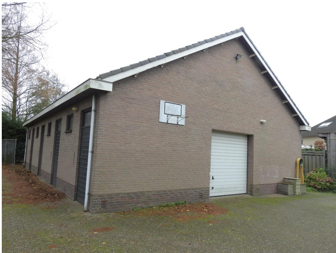
Figuur 2.2 Noordzijde van de te slopen schuur.
