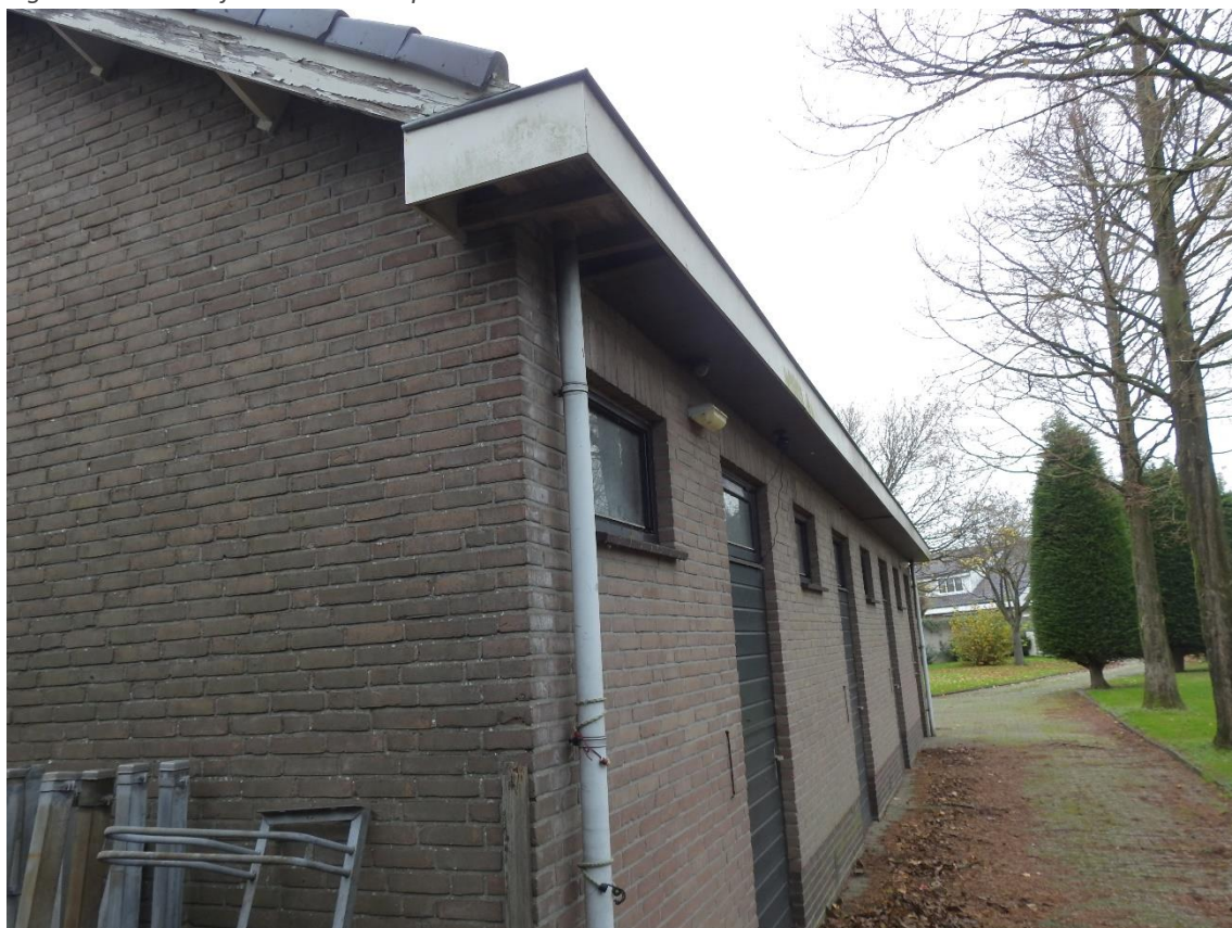
Figuur 2.3 Oostzijde van de te slopen schuur.
