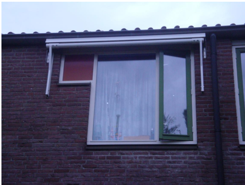
Foto 3 Paarverblijf onder vensterbank
