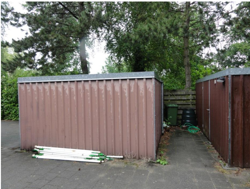
Foto 3 Stalen bergruimtes aan de noordkant.
