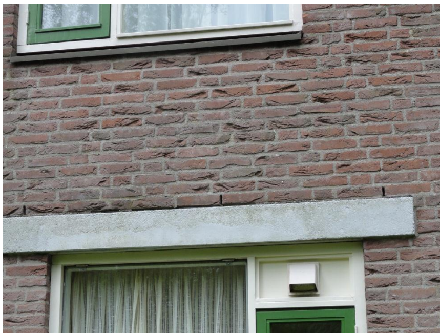
Foto 4 Openingen in gebouw geschikt voor vleermuizen.
