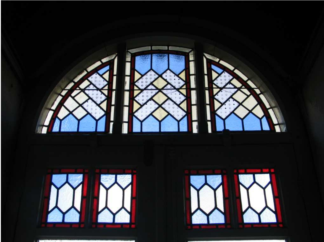
Oorspronkelijke beglazingen dakopbouwen
