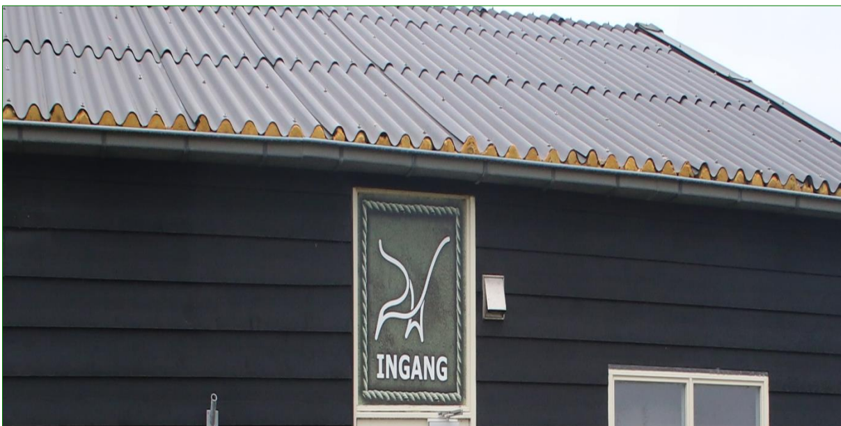
Onder de golfplaten zijn ruimtes dichtgezet met isolatiemateriaal.
