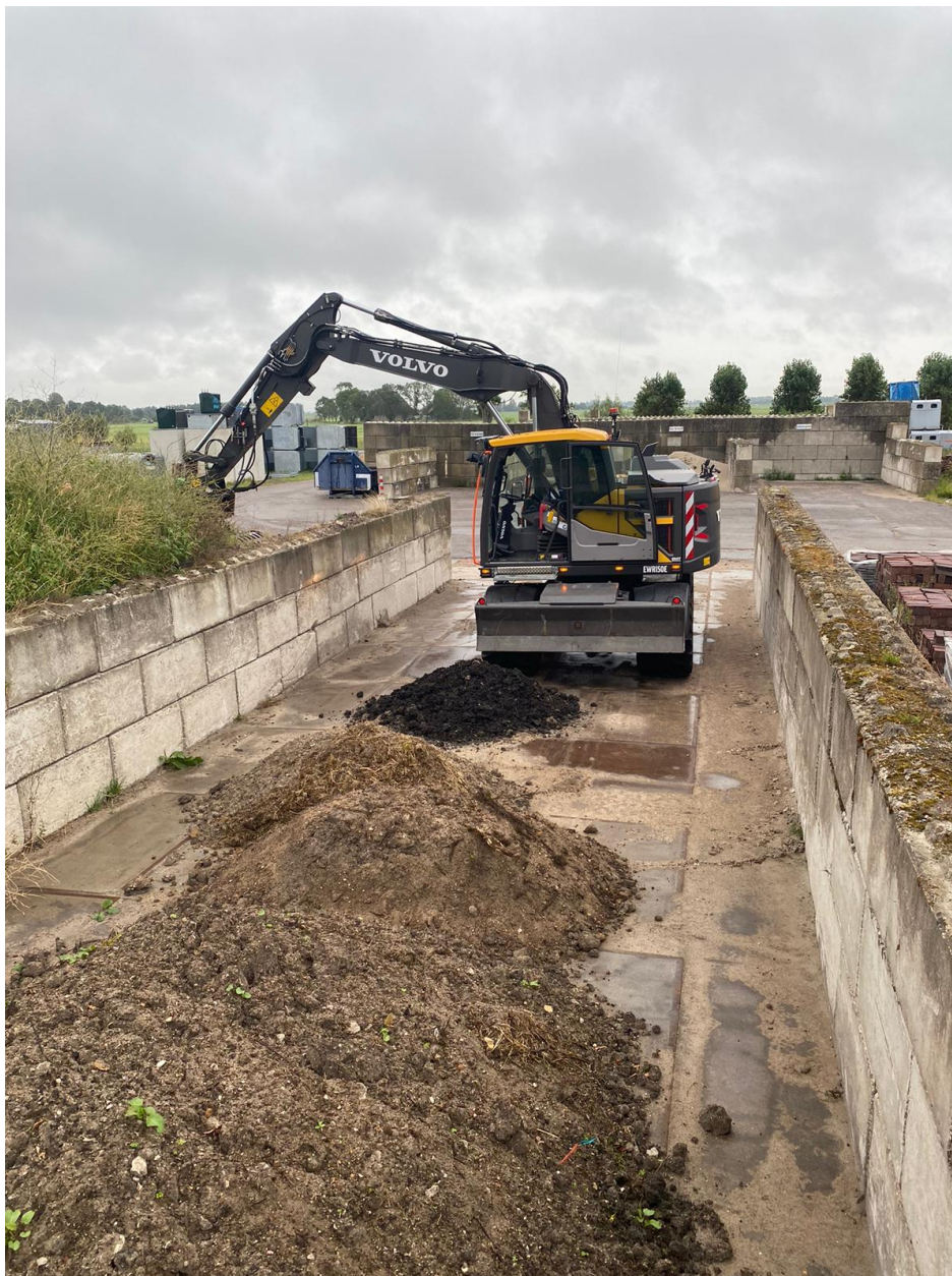
figuur 9: Werkvak / depot met verschillende partijen grond + opstelruimte voor graafmachine (bron: gemeentedept). De werkvakken aan de Hoogeweg hebben een dusdanige omvang (198 m/depot) dat ook het opstellen van een tractor met kipwagen / vrachtwagen BINNEN het werkvak plaatsvindt !
