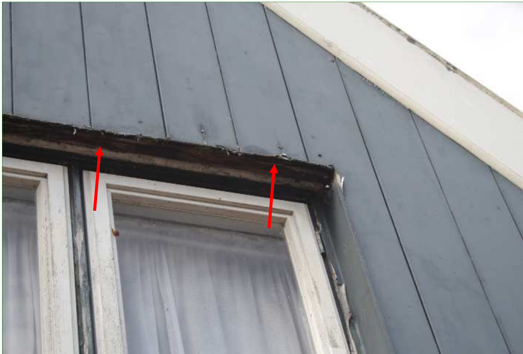
Spleten boven de kozijnen geven mogelijk toegang tot voor vleermuis geschikte achterliggende ruimtes.
