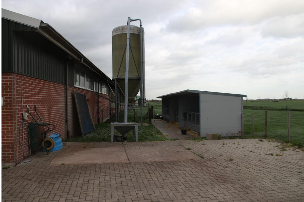
Bestaande stal met silo en kokken voor kalveren naast de uitbreidingslocatie
