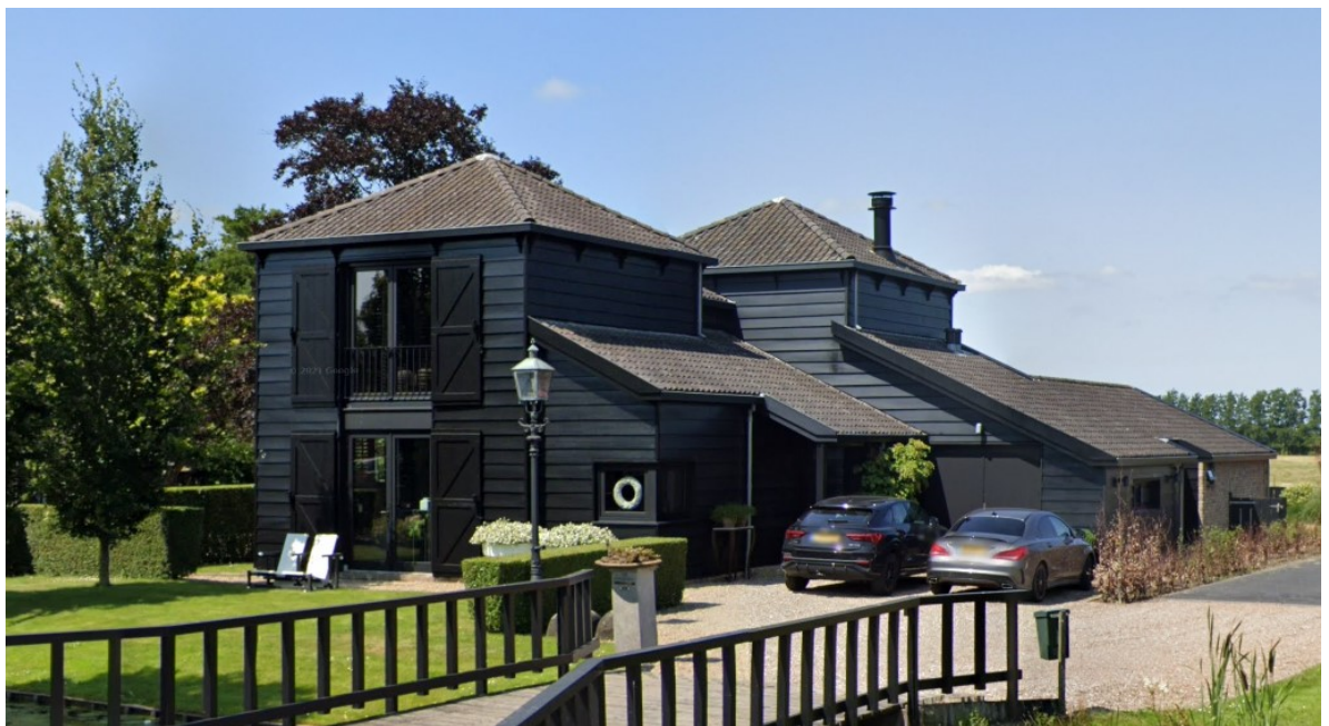
Referentieproject nieuw bijgebouw
