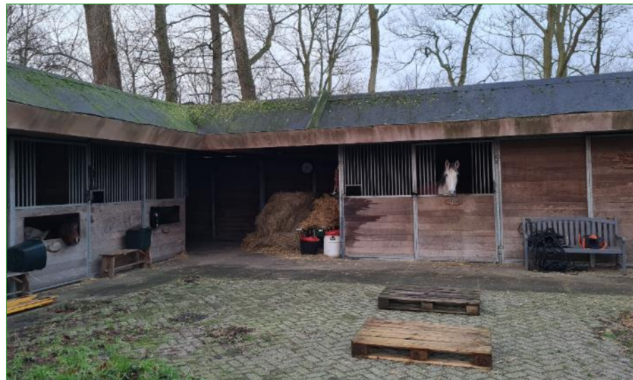
Paardenstal 1, aan de westkant van het plangebied.
