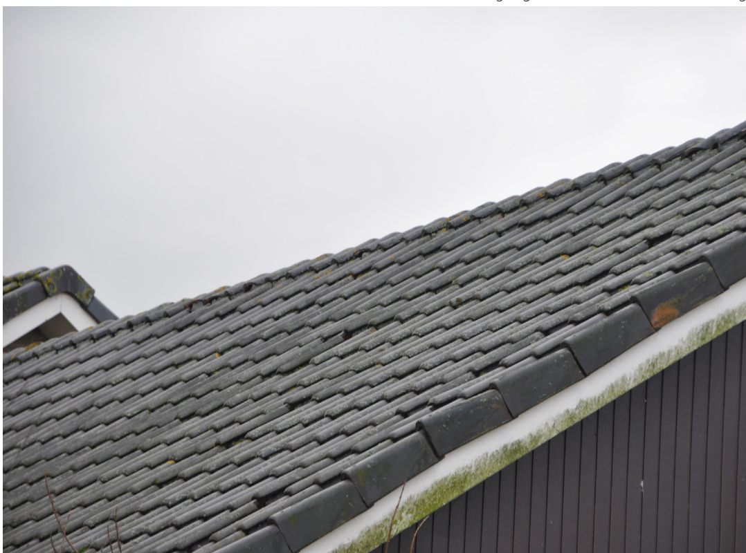
In het dak zijn verschillende geschikte openingen voor vleermuizen.
