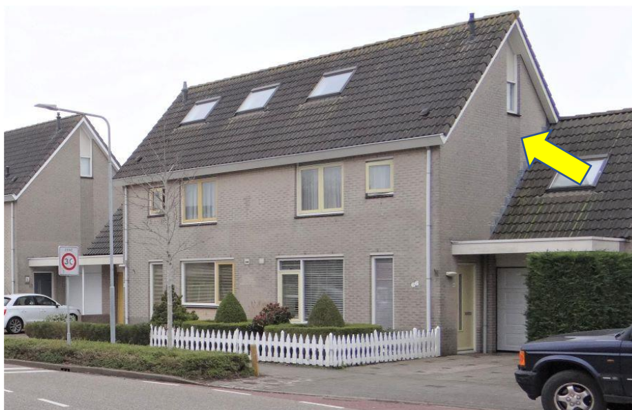
Foto 1. De locatie van de kolonieverblijfplaats van de Gewone dwergvleermuis. Het planperceel grenst direct aan de kopzijde van de hier zichtbare garage.
