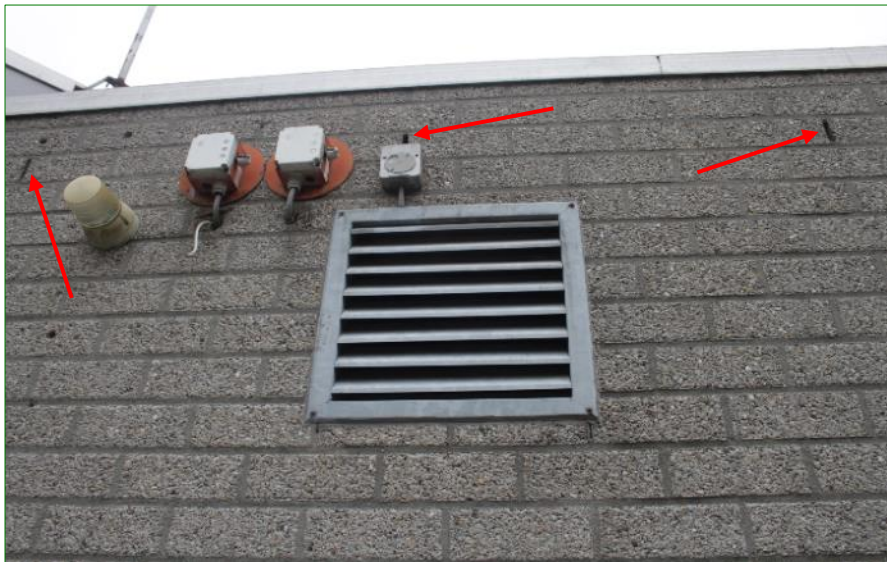
Spouwgangen bieden mogelijk toegang tot voor vleermuizen geschikte achterliggende ruimtes.
