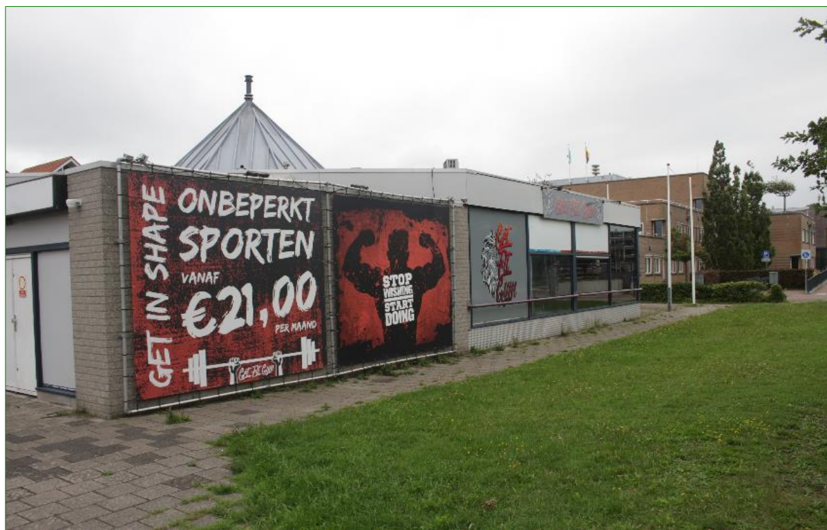
Aanzicht van de noordwestzijde van de bebouwing met bakstenen muur, grotendeels afgedekt door een spandoek..
