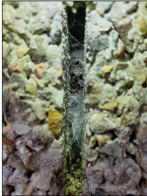
Één van de onderzochte spouwgaten. De spouwgaten zijn geheel afgesloten met spinnenwebben.
